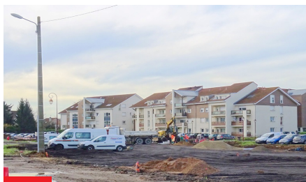
Un nouveau parc, d'une centaine de places, est en cours d'aménagement (nov. 2016) – Doc. Aguram
