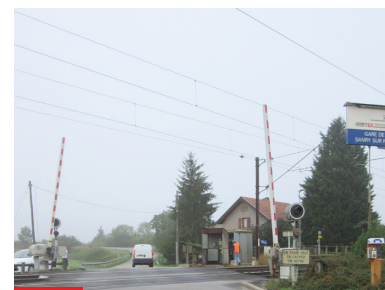
Un passage à niveau, une route de rase campagne sans trottoirs... La gare n'est pas accessible aux piétons, et à peine aux cycles. - Doc. Aguram
