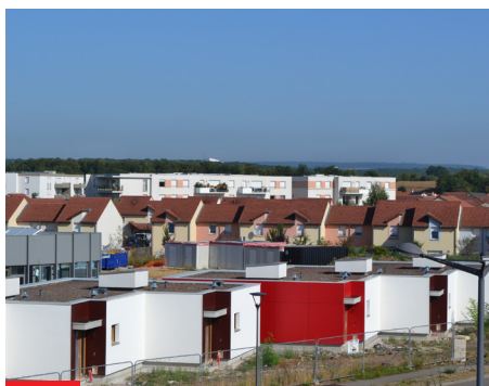
Habitat collectif, maisons en bande, Quartier Val Madeira.
