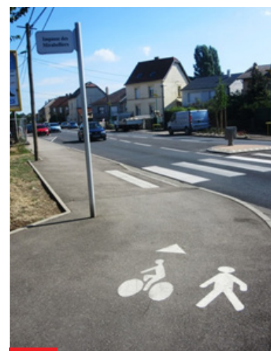
Trottoir partagé à proximité de la gare. Un équipement inadapté à l'usage du vélo comme moyen de transport – Doc. Aguram
