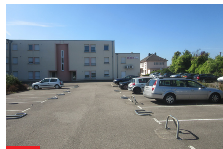
Les stationnements privés situés à proximité de la gare ne semblent pas occupés par les usagers, mais ils sont protégés... - Doc. Aguram
