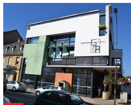
Médiathèque Georges Brassens, Grand'Rue.
