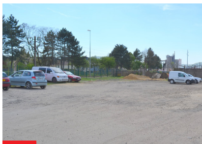
Le parking de la halte ferroviaire de Gandrange-Amnéville, une capacité suffisante, mais un équipement très peu qualitatif - Doc. Aguram
