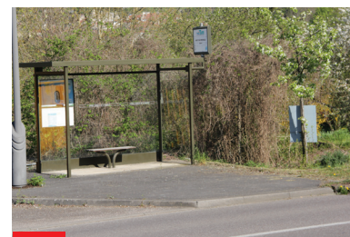
L'arrêt TIM (dans le sens Metz - Gorze), à proximité immédiate de la gare – Doc. Aguram
